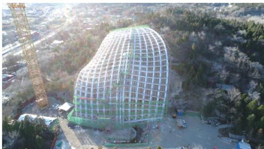
图2 建设中的钢网壳实景
